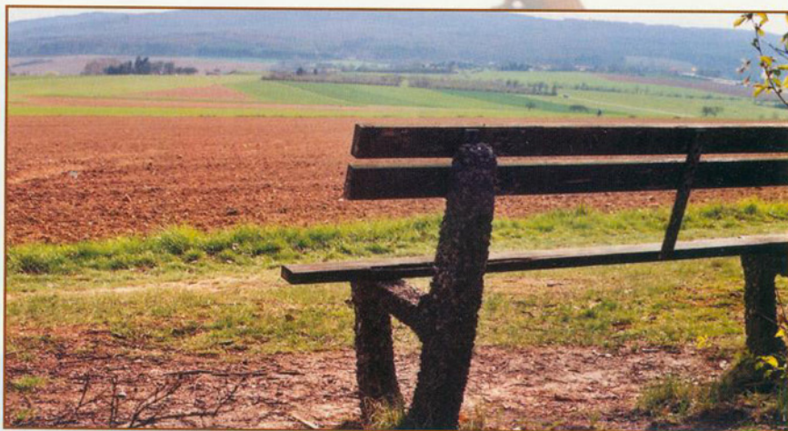
Taunusblick – die Bänke warten noch auf eine Reparatur.
